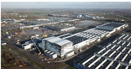
Chantier de la Gigafactory de Billy-Berclau Douvrin (© ACC)
