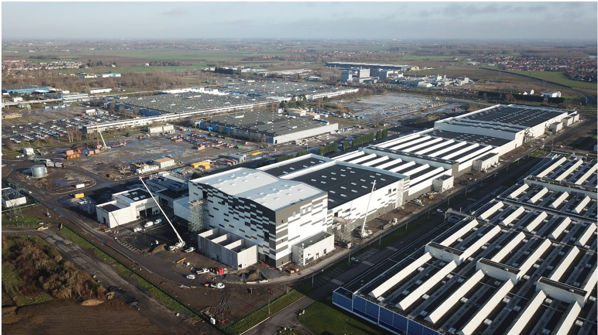
Chantier de la Gigafactory de Billy-Berclau Douvrin (© ACC)
